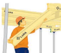
Placer les poutrelles secondaires perpendiculairement aux premières en respectant les écarts indiqués sur le tableau des charges.
